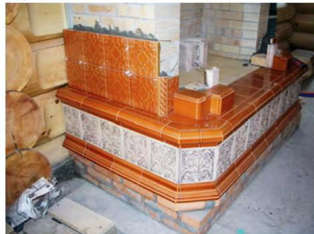
При монтаже изразцов важно следить за положением каждого и толщиной швов.
