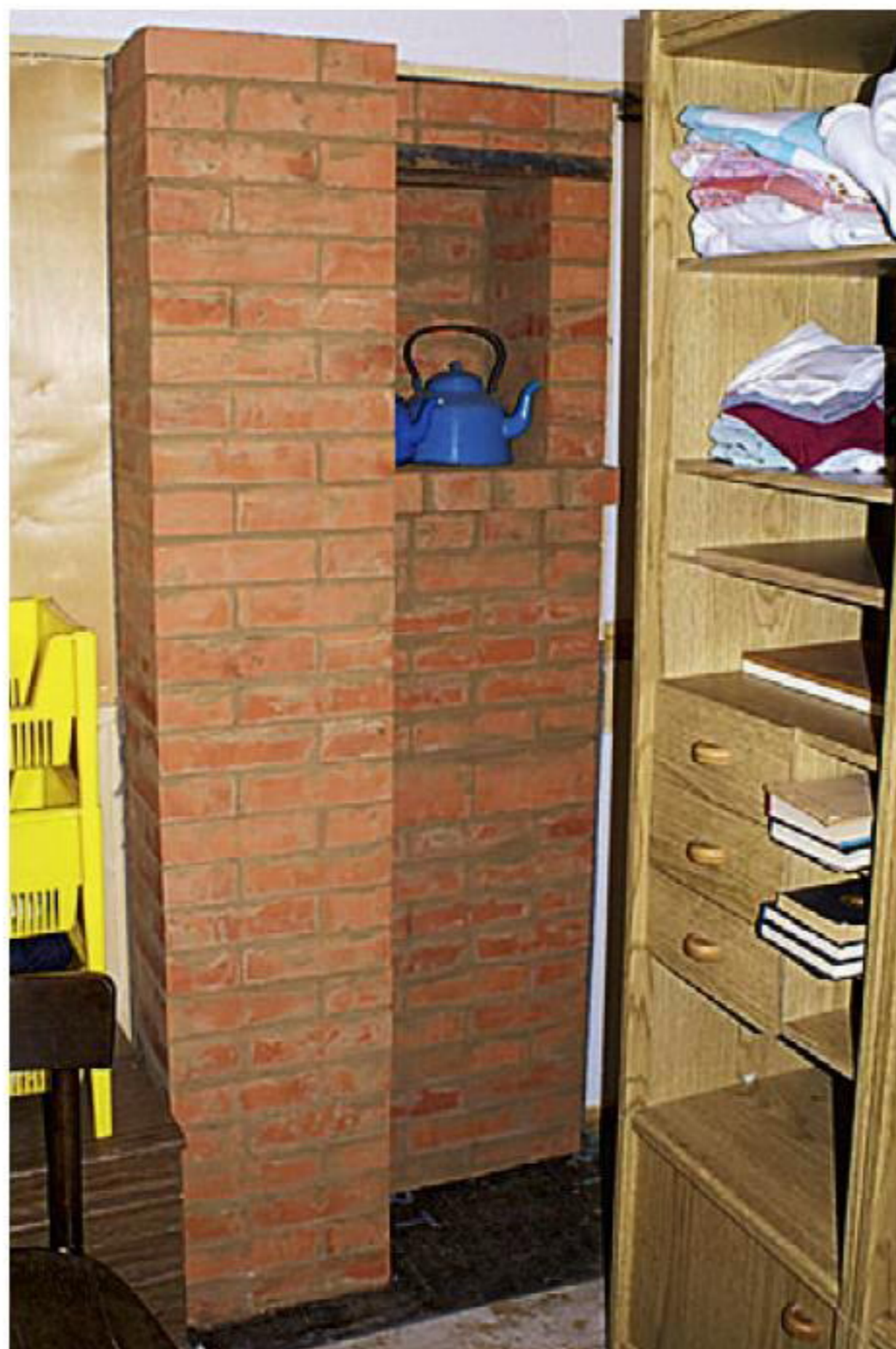
Тыльная сторона той же печи во второй комнате. Ниша в печи может использоваться для подогрева воды и еды.
