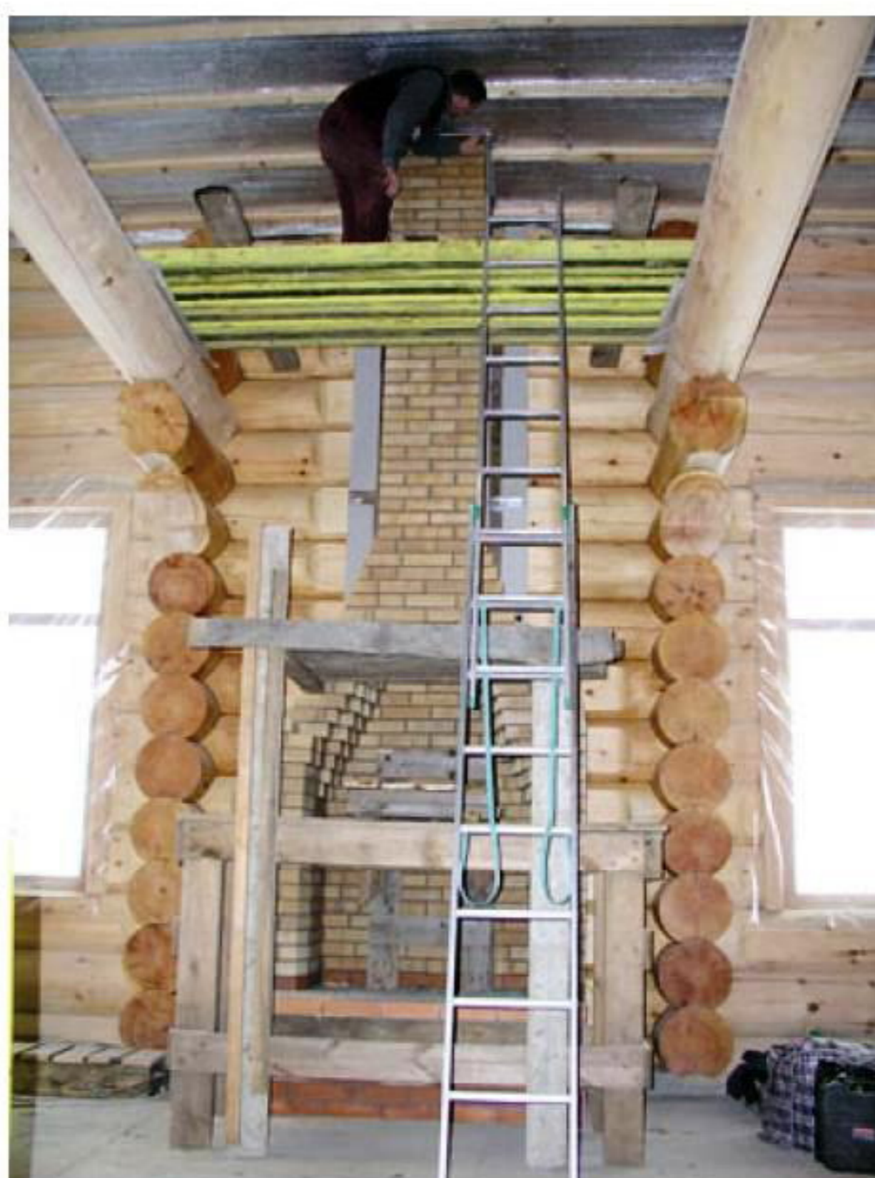
Для кладки трубы пришлось соорудить леса.
