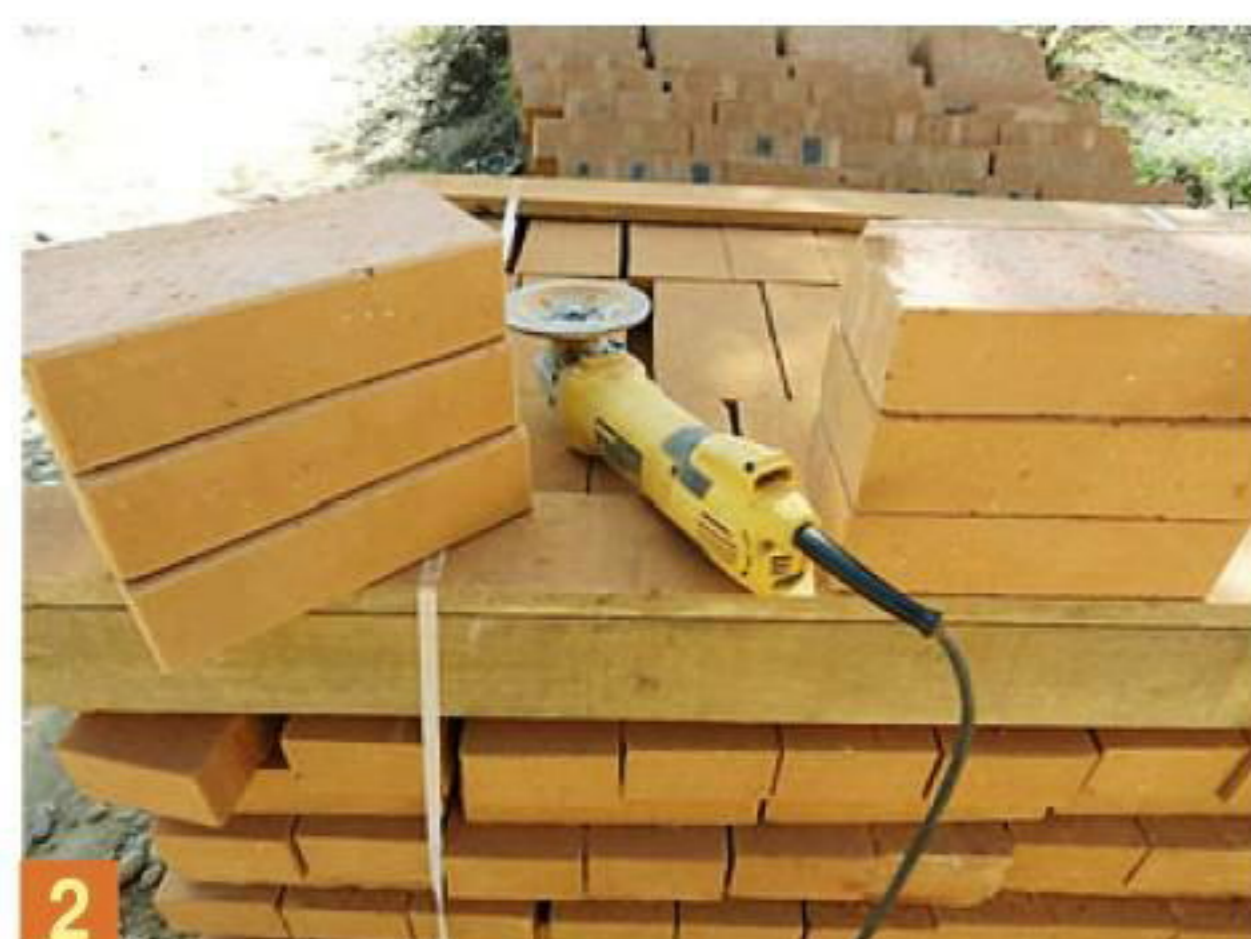
2 Чтобы кладка выглядела аккуратнее, с наружных рёбер болгаркой снята фаска.
