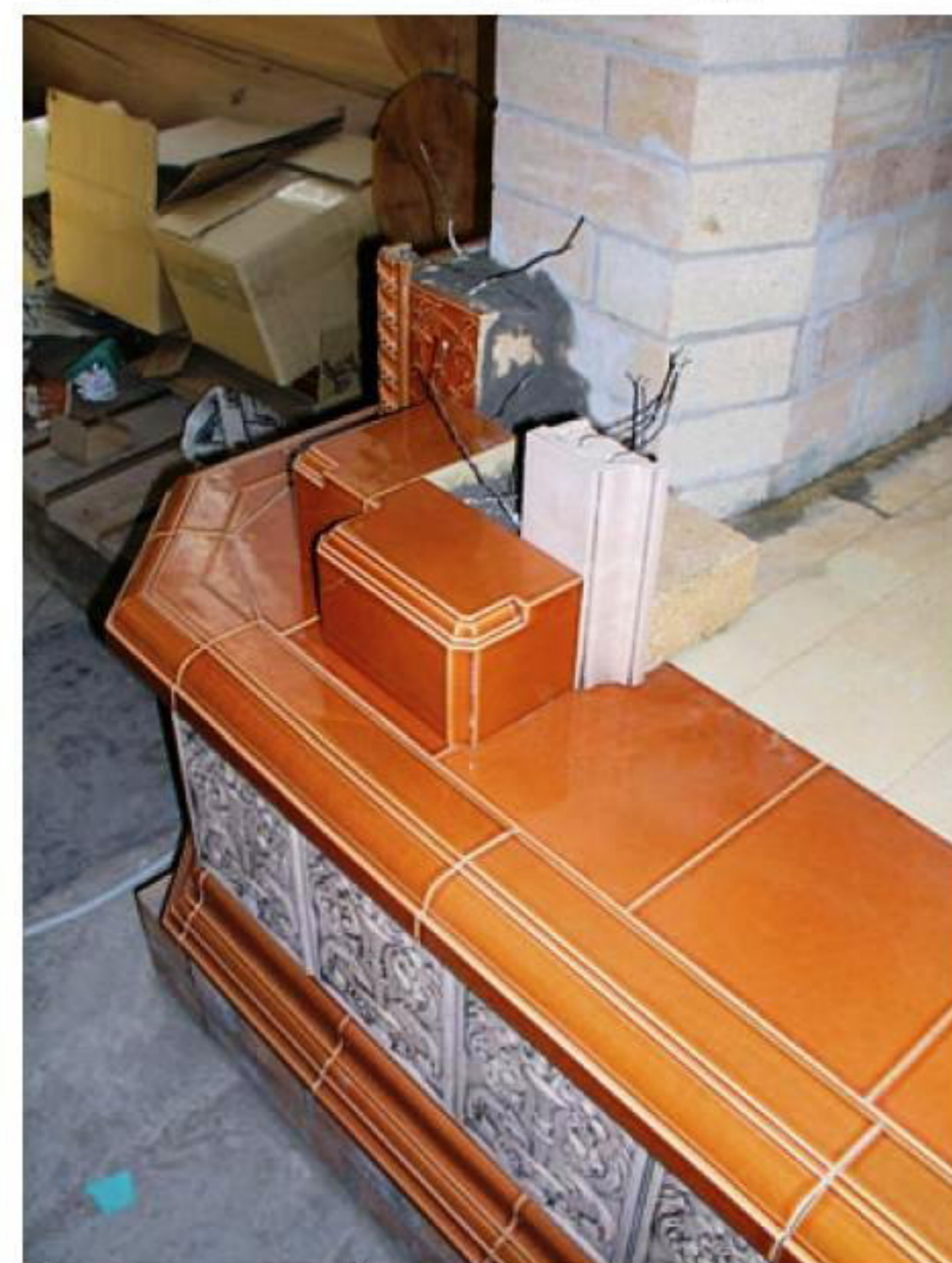
Ответственный момент — установка изразцов основания колонны.
