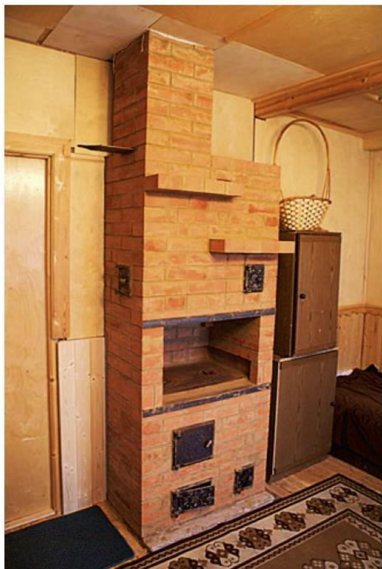
Типичная «шведка» (фасад) с декоративными полочками служит для отопления двух комнат и приготовления пищи.
