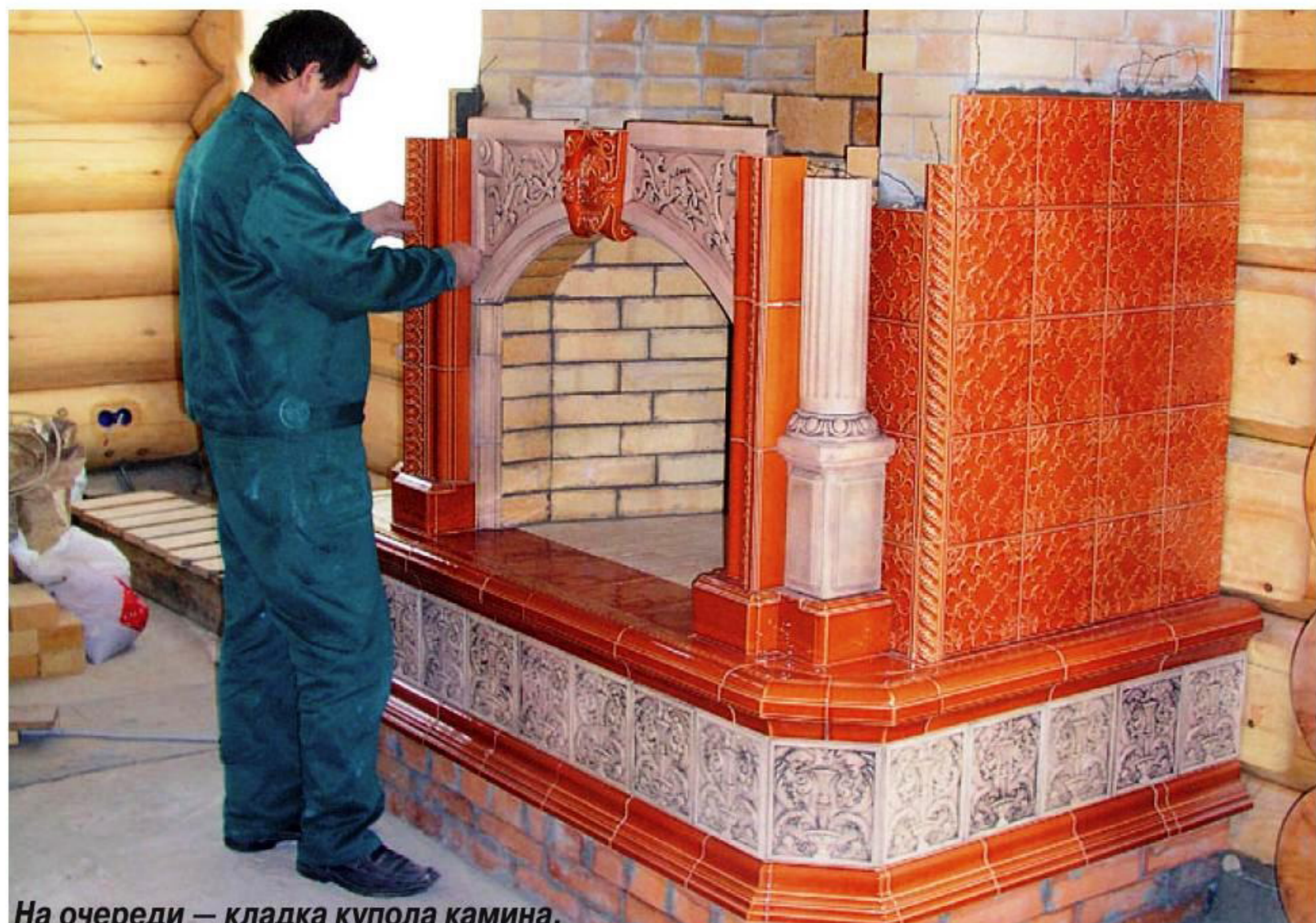
Начата кладка наклонной задней стенки топки.
