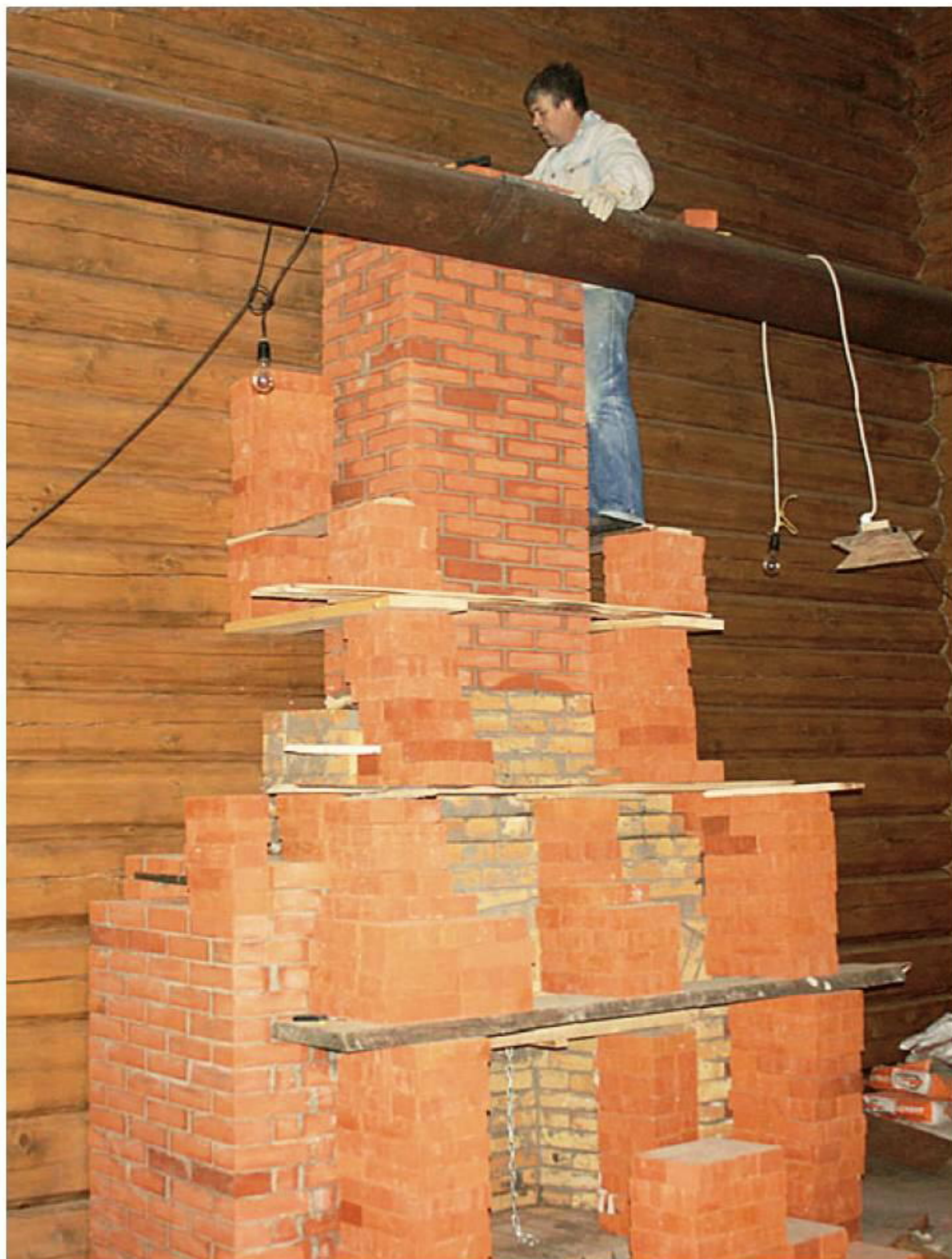
Кладка кирпичного дымохода из керамического кирпича. Температура дымовых газов в трубе камина невысока, поэтому для этой работы можно использовать цементный раствор.
