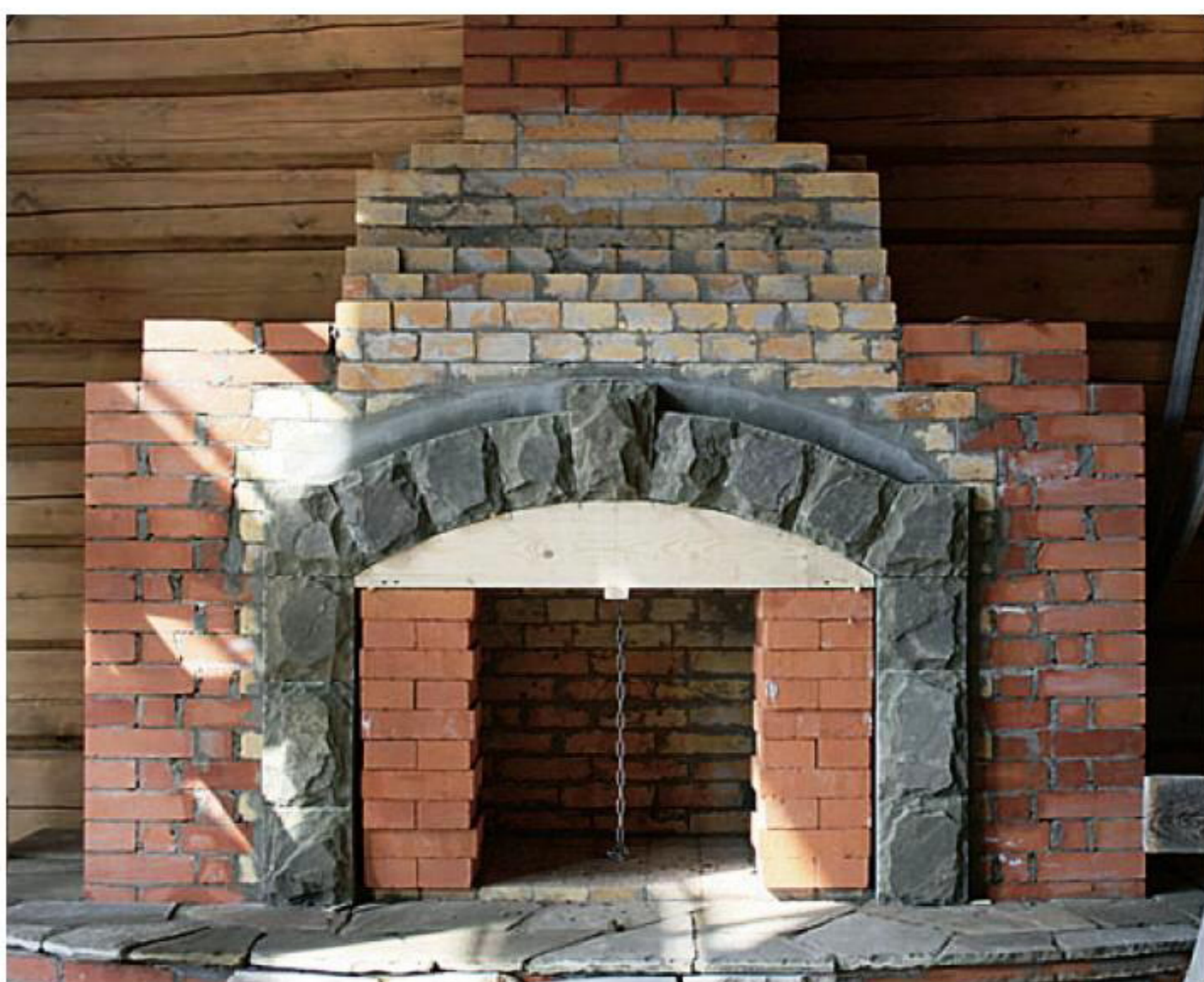
Отделку портала начали с облицовки арочной перемычки.
