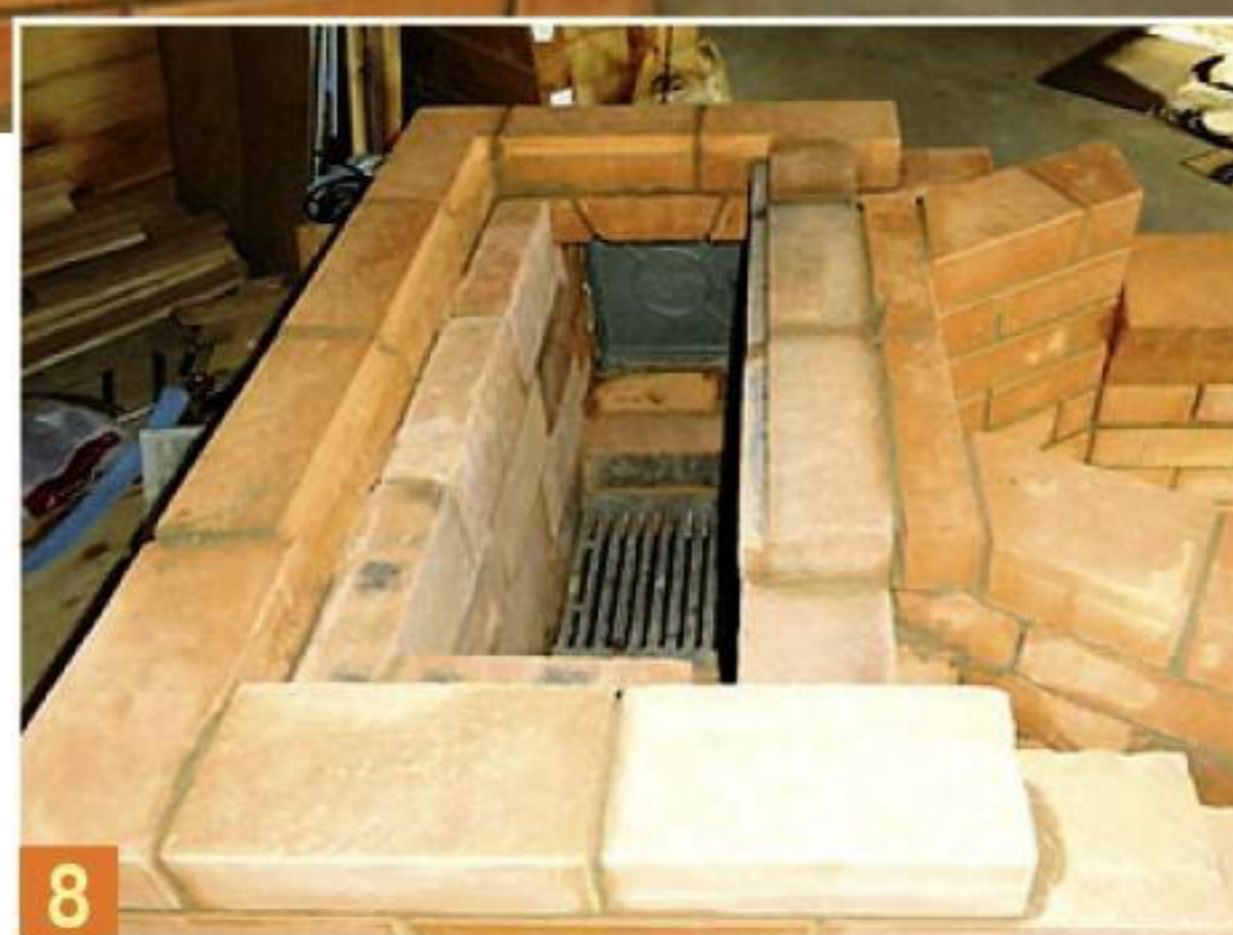
8 Для установки чугунного настила в кирпичах выбрана четверть.
