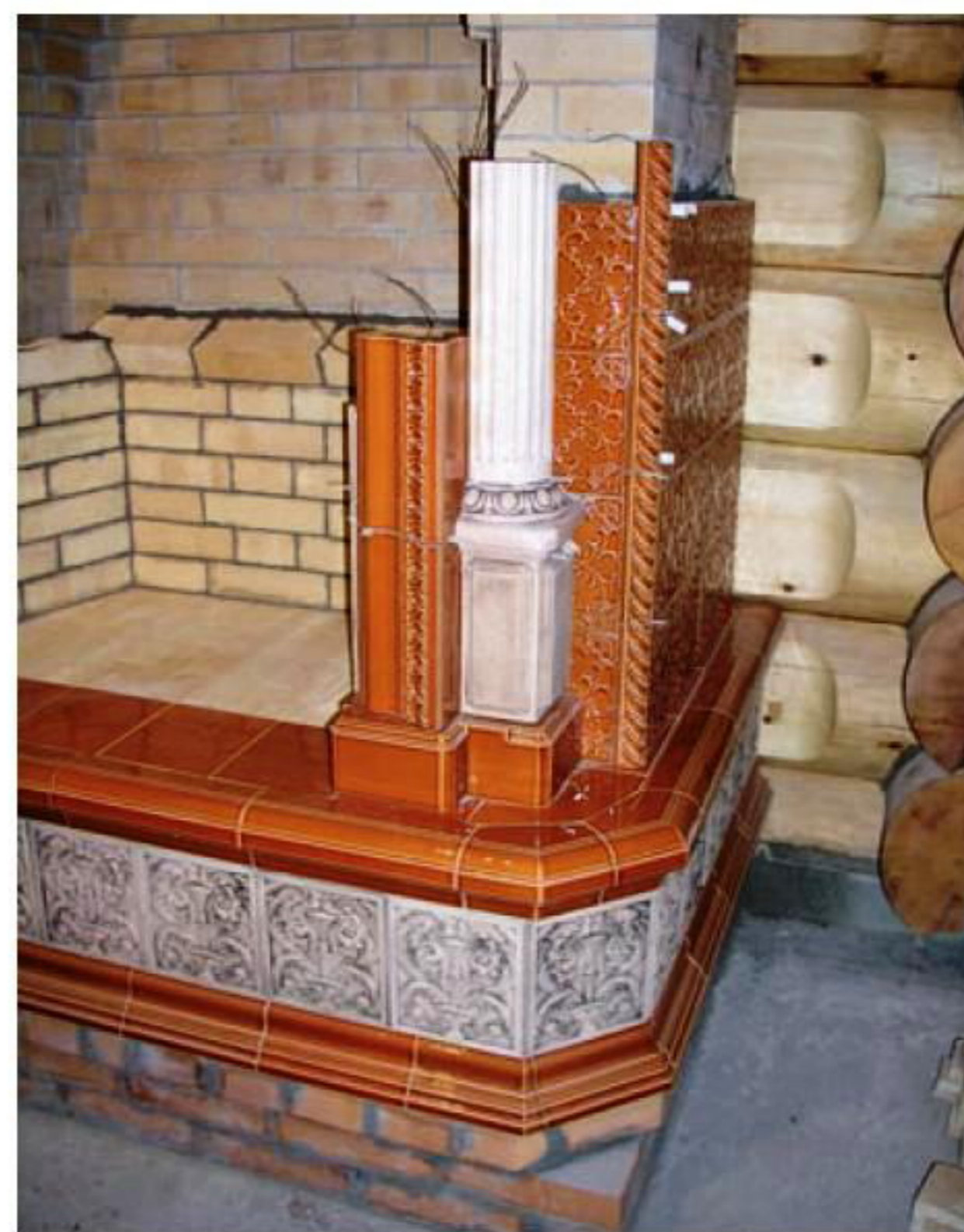
Начата кладка наклонной задней стенки топки.
