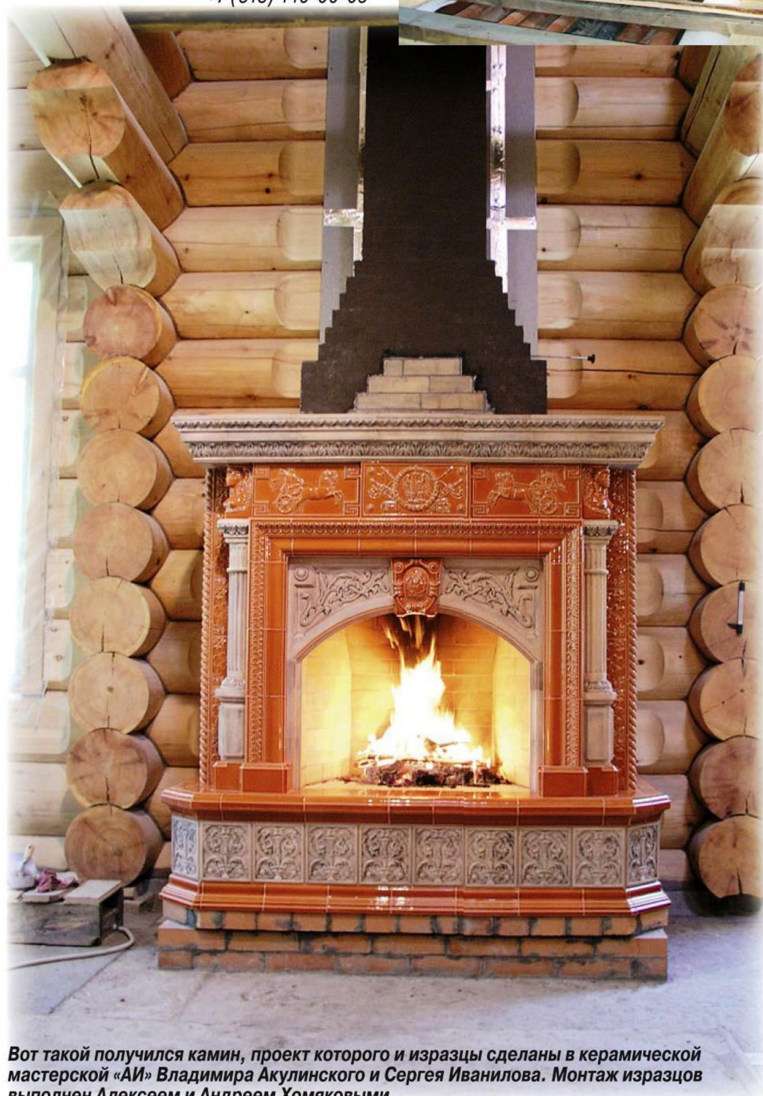
Монтаж изразцов близок к завершению. На очереди — карниз и полка камина.
