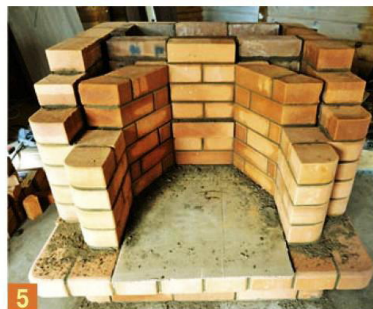
5 В топке камина (на 9-м ряду кладки) кирпич фронтальной стенки немного выдвинут. Этот выступ пригодится при жарке шашлыка.
