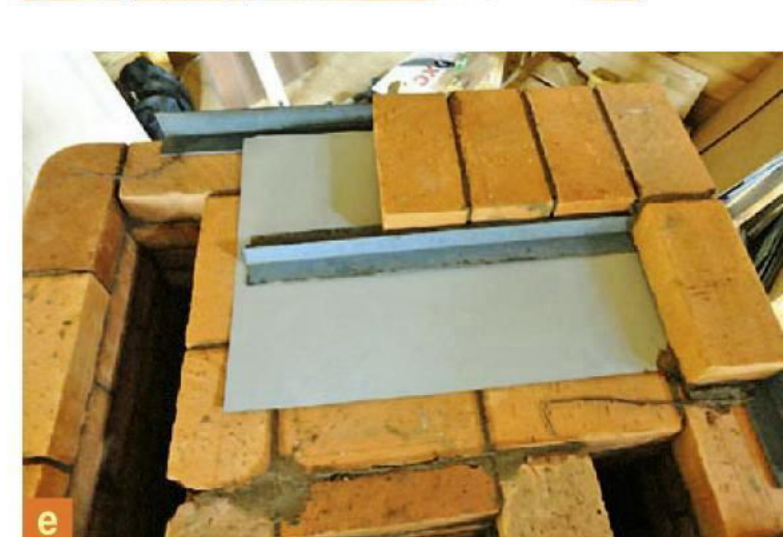
Последовательность операций при установке перекрытия варочной камеры.
