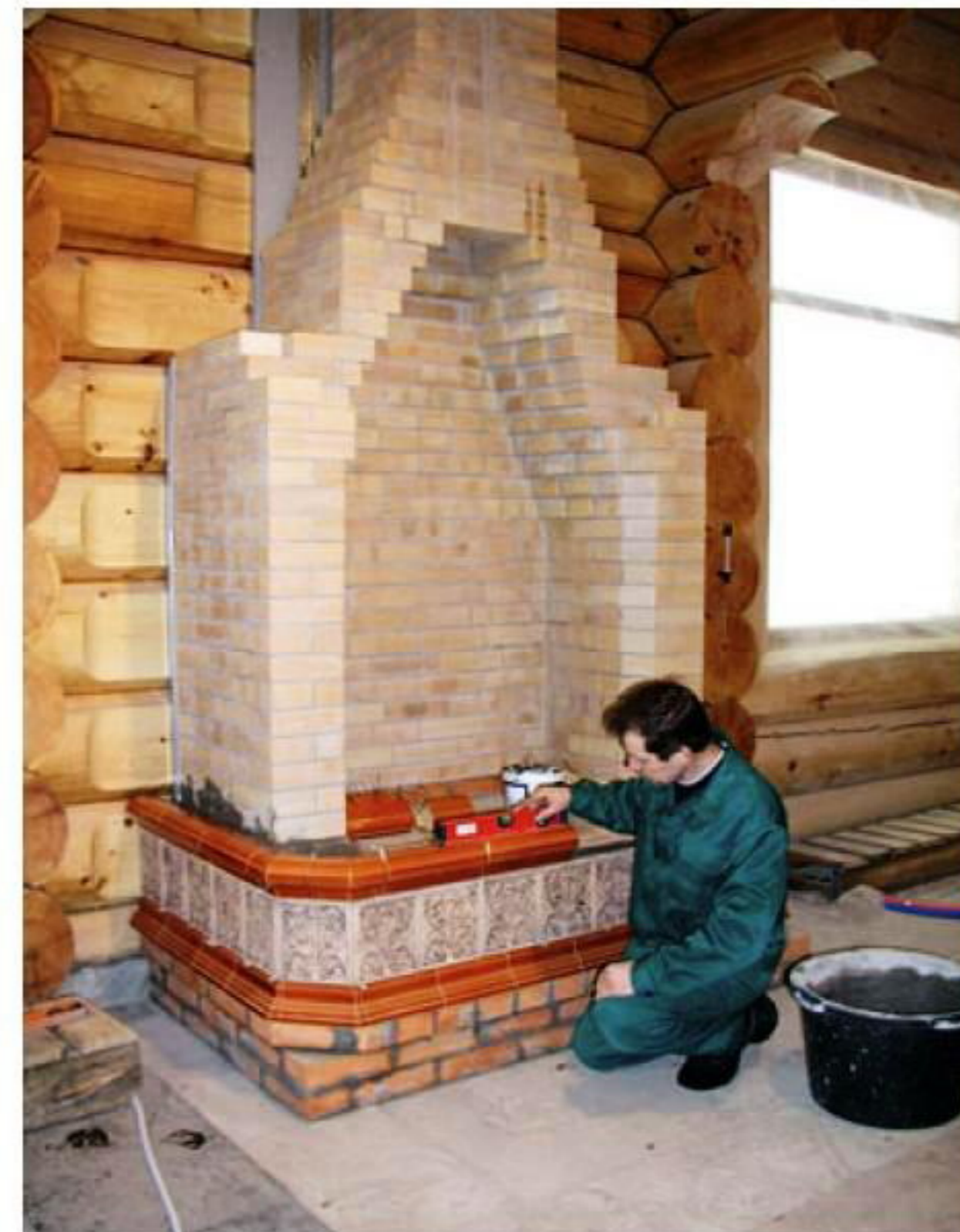
Начиная с первых изразцов подиума вёлся постоянный контроль кладки.
