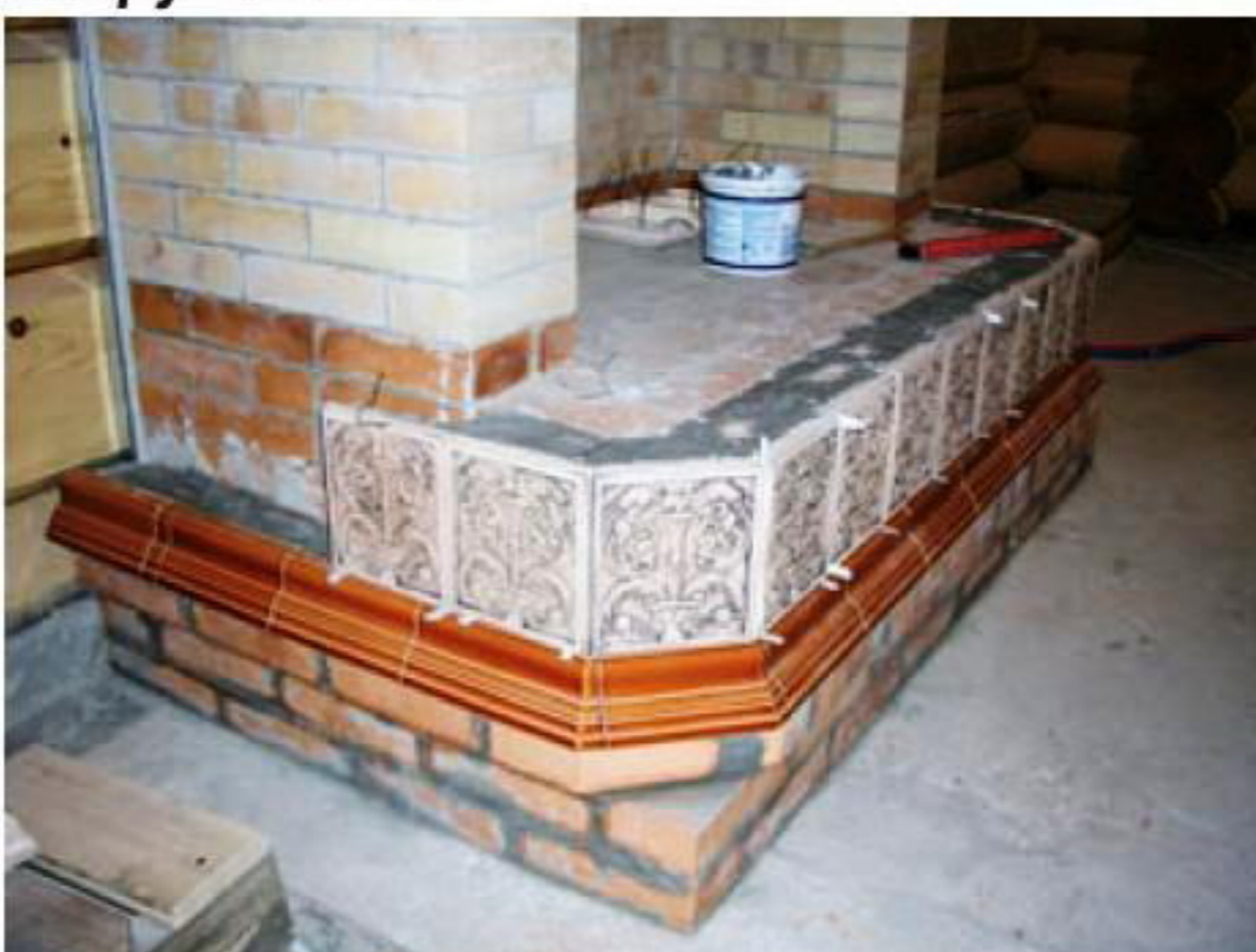
Монтаж изразцов подиума.
