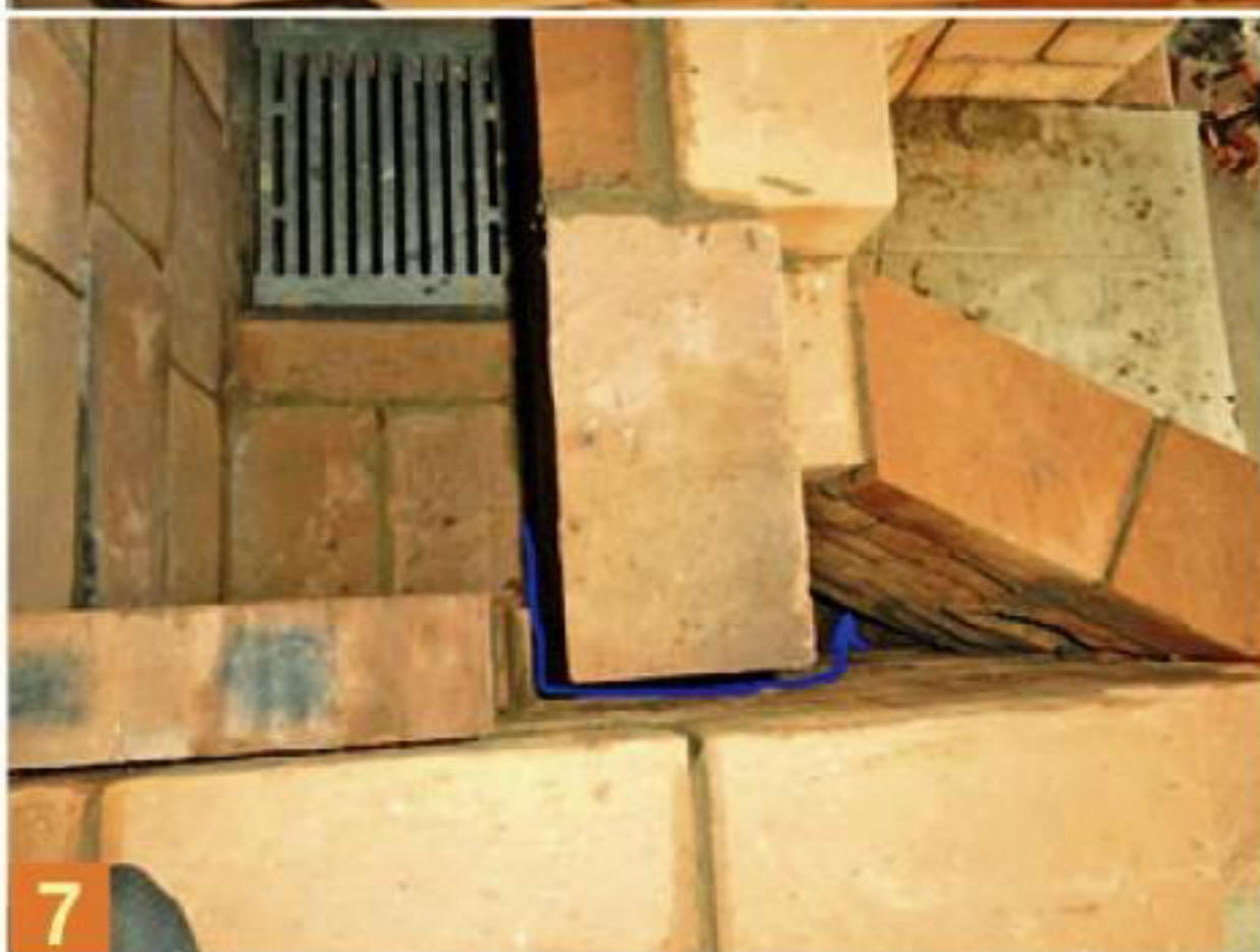
7 В углу топки печи сделан сухой шов (он показан синей стрелкой).
