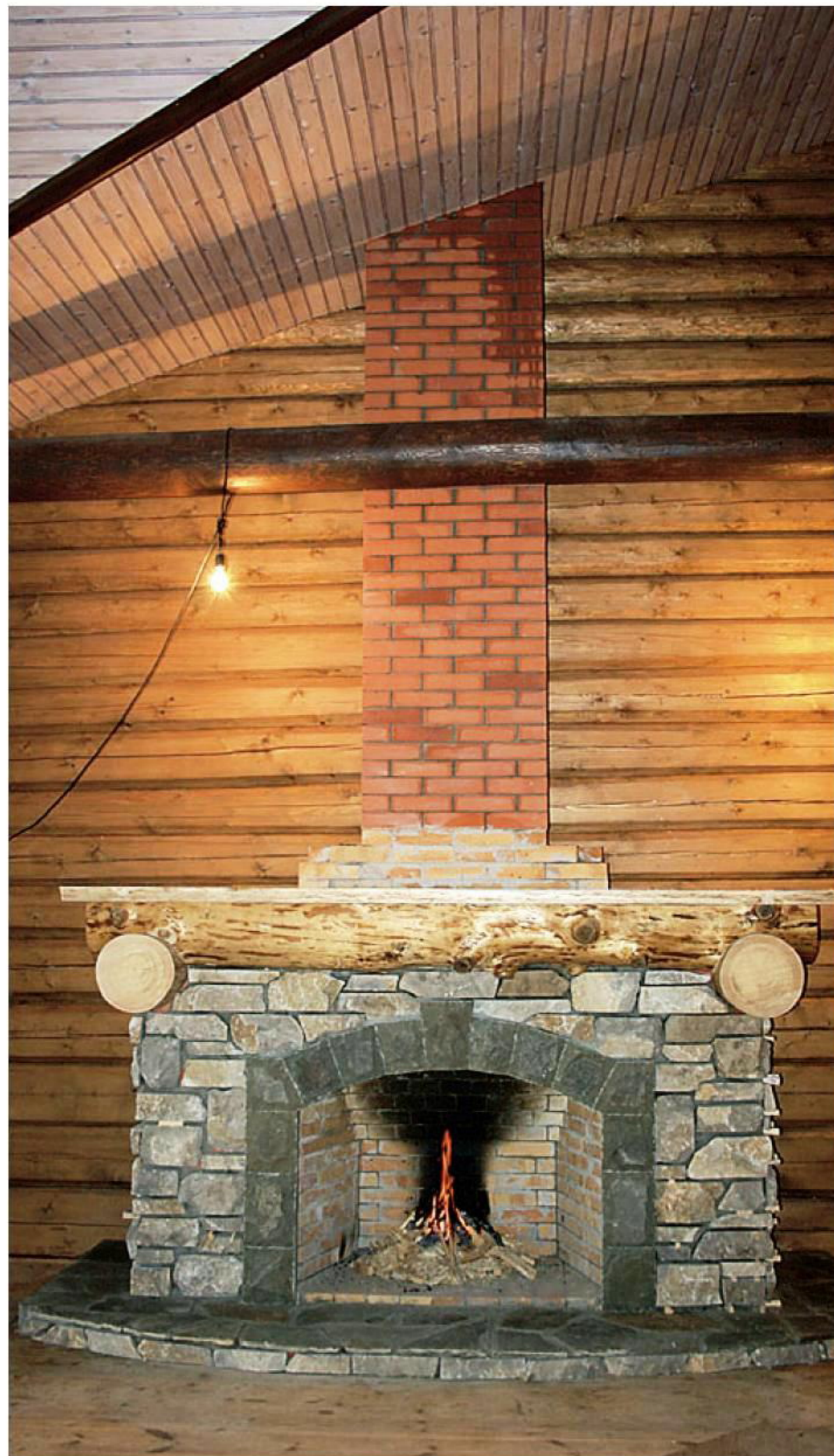
После отделки портала камнем была установлена и закреплена анкерами в кирпичной кладке сосновая полка.
