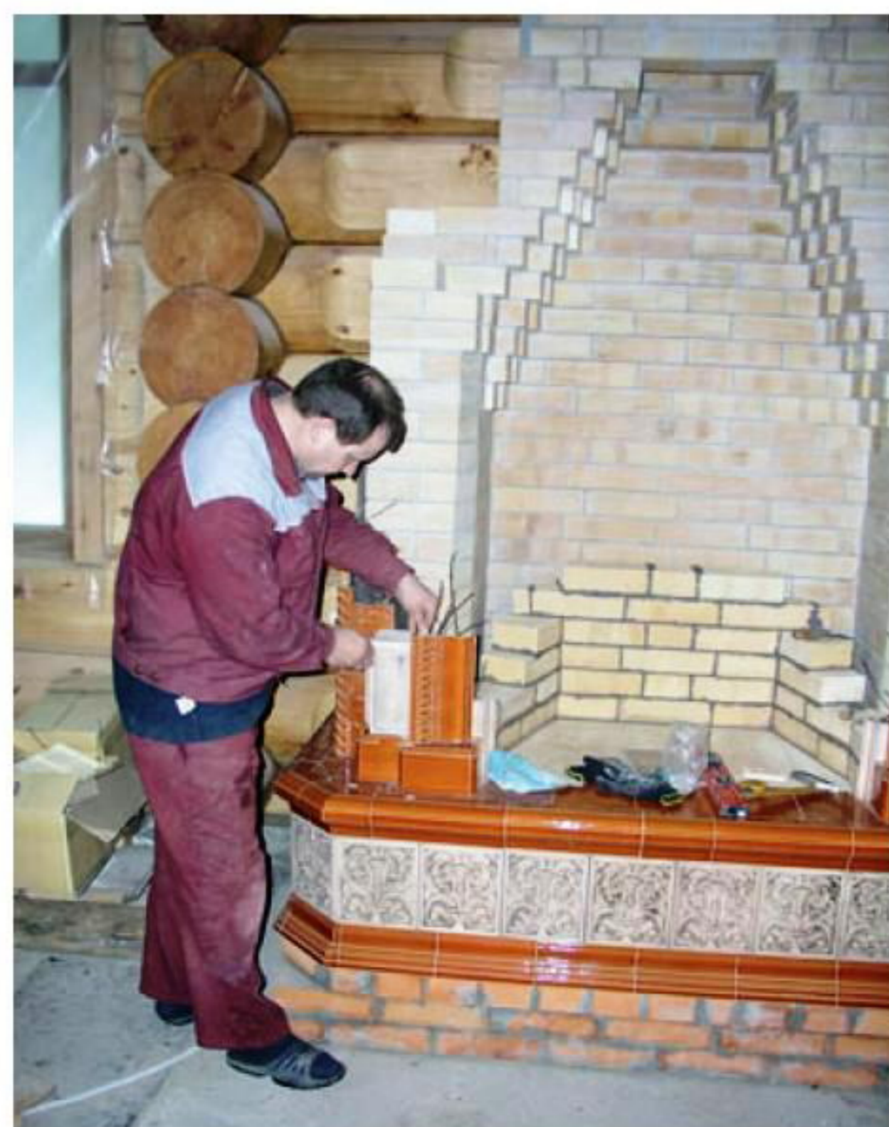
При монтаже изразцов одновременно велась и футеровка топки.
