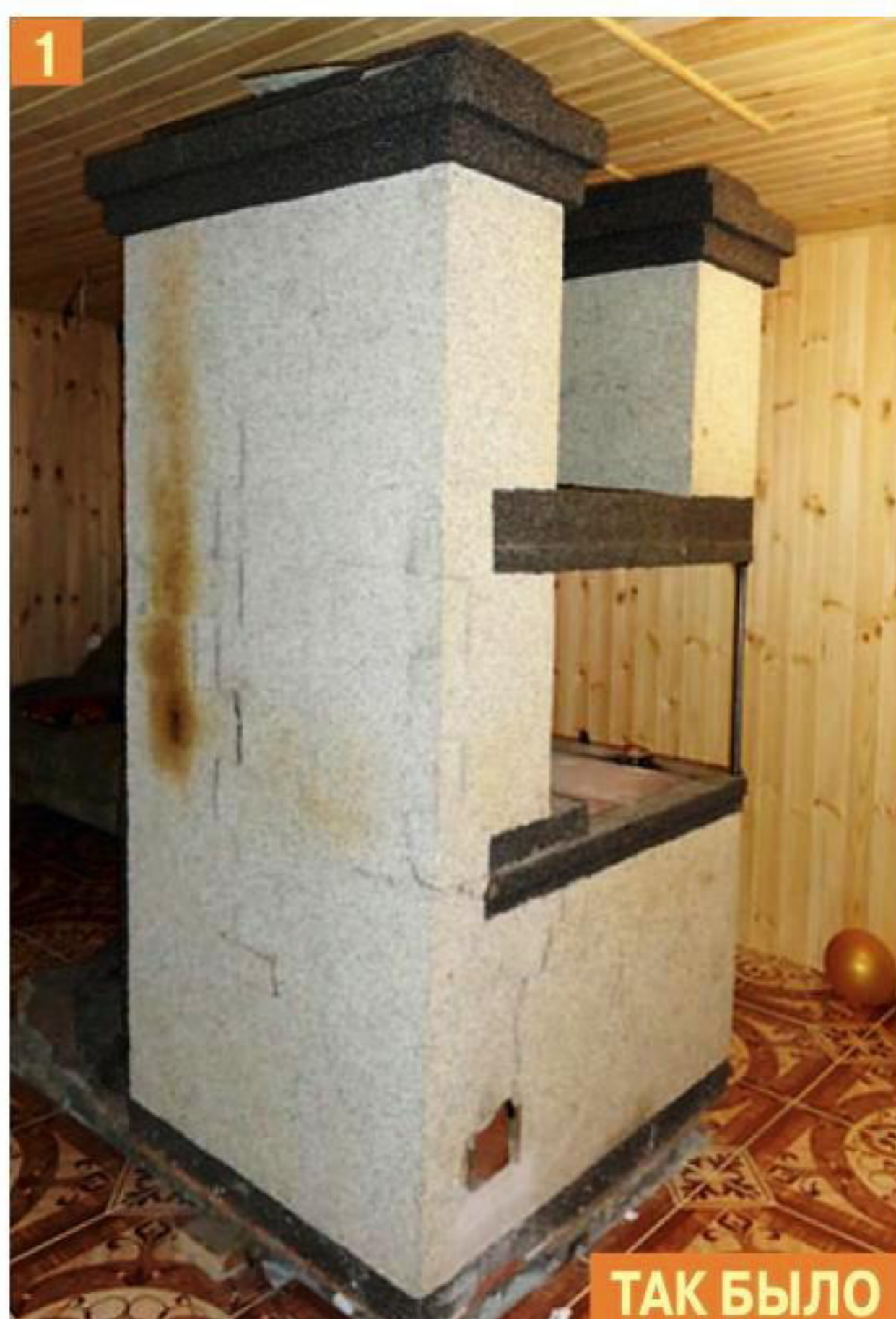
1 Старая печь покрылась трещинами...
