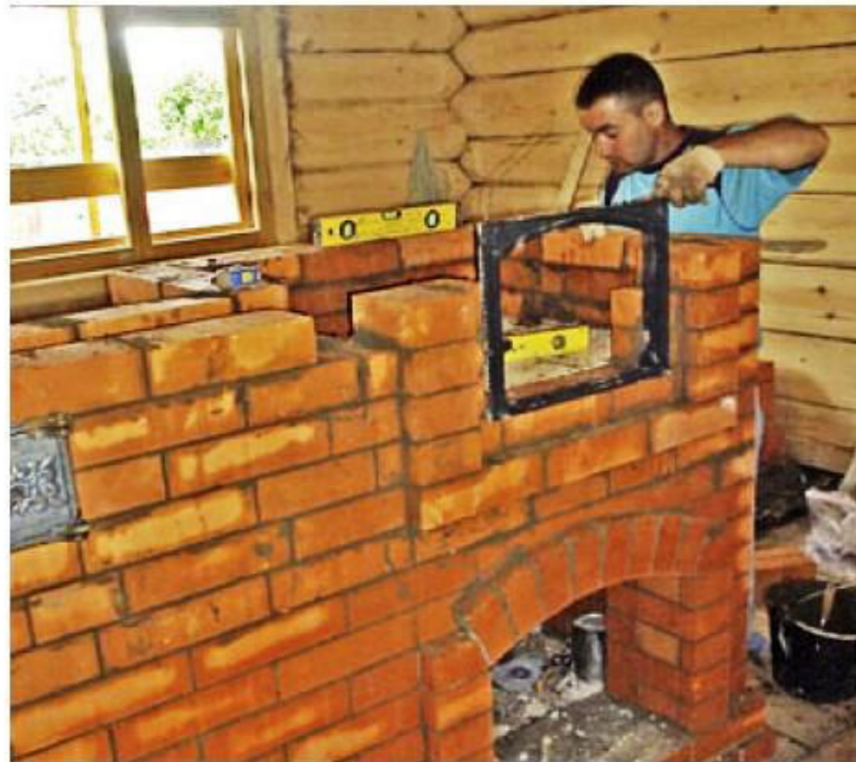
Установлена рамка дверки хлебопекарной камеры. Сама дверка будет навешена на петли позже.
