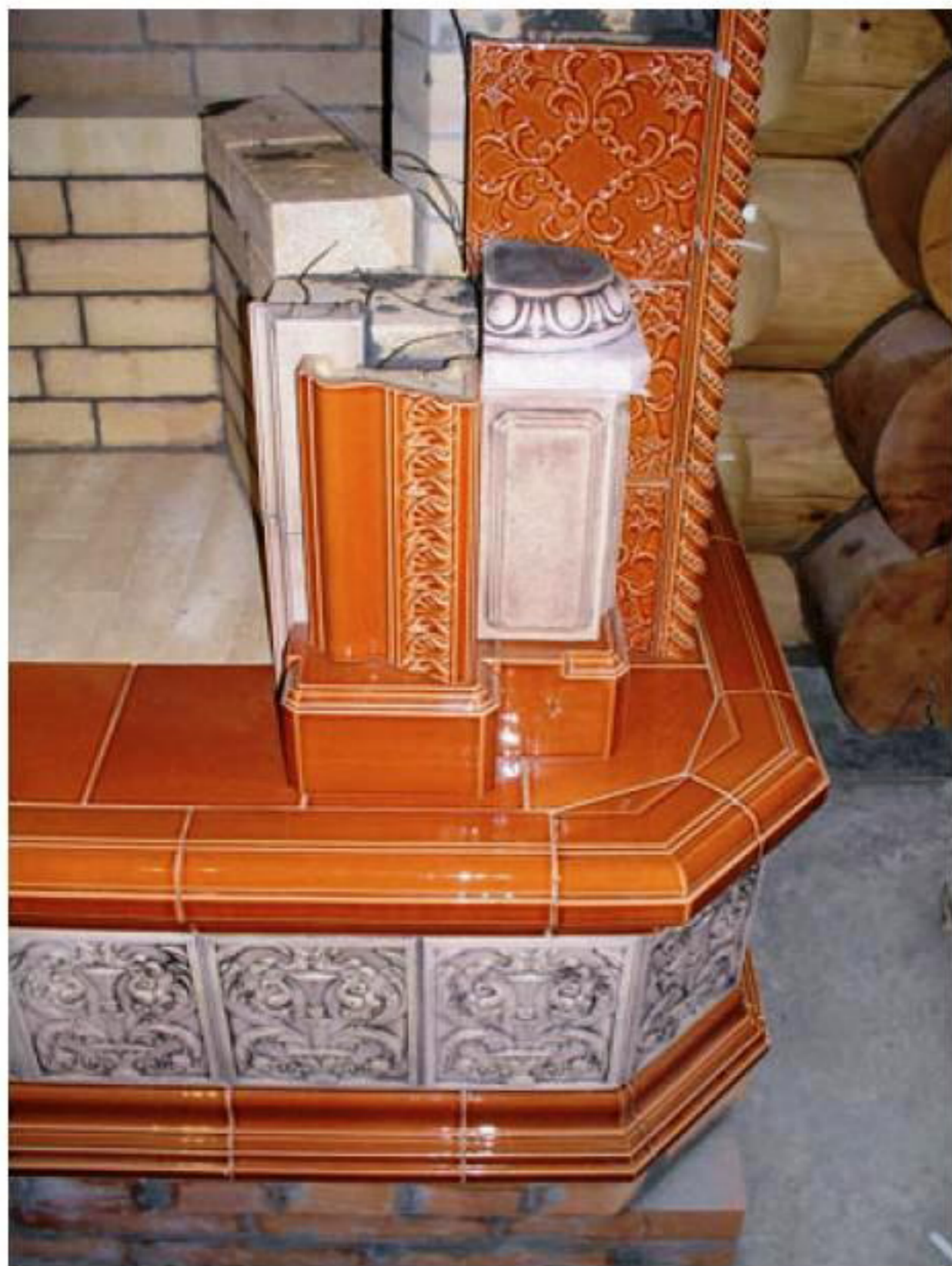
Монтаж изразцов портала и колонны.
