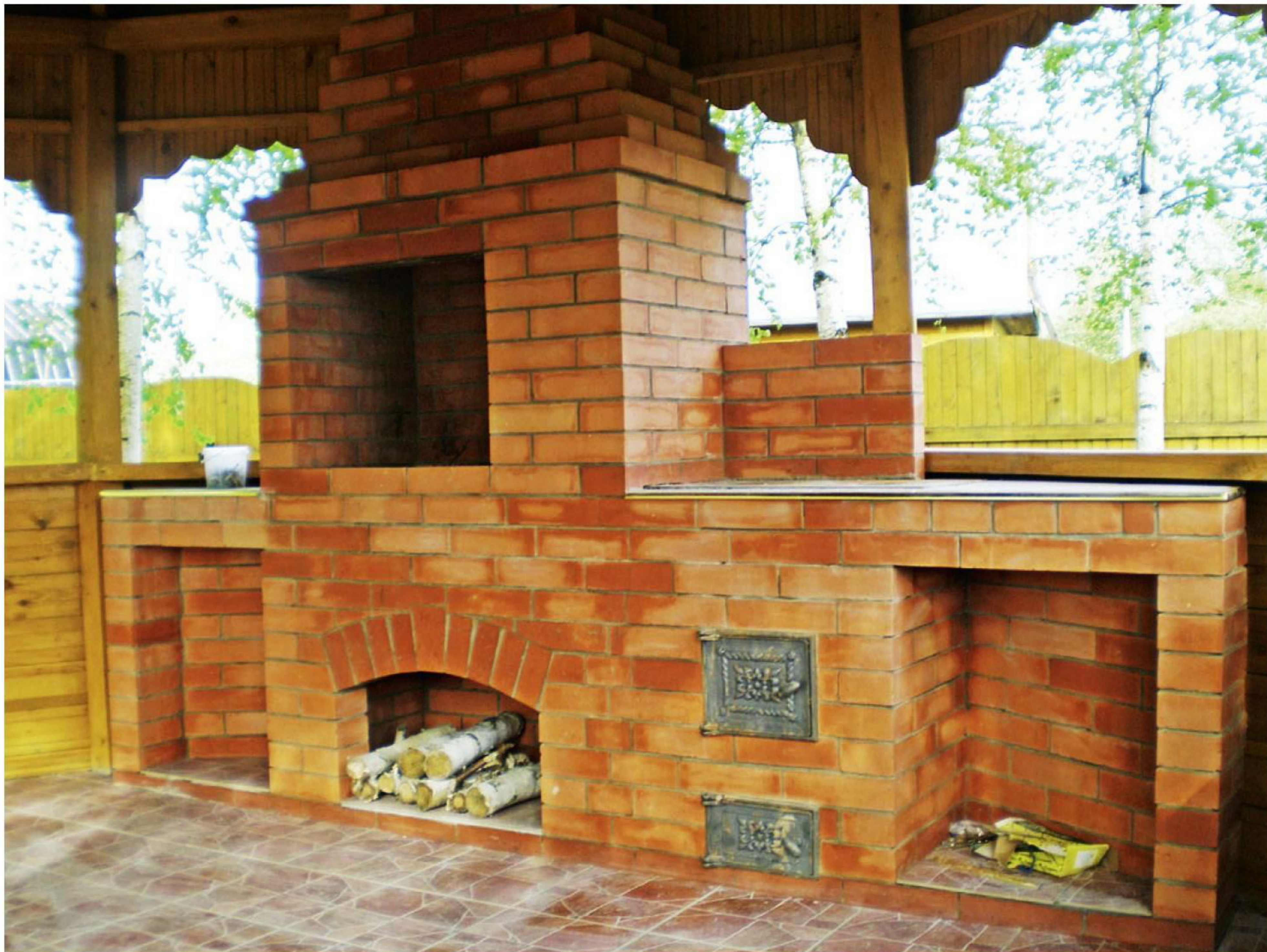
Уличный камин с дровницей, кухонной плитой и двумя столешницами. Правый заплечик камина шире левого в три раза. Эта часть является дымоходом плиты, который объединяется с дымоходом камина в одну трубу. Уровень расположения плиты такой же, как и у бытовых (газовых, электрических и др.) плит — 0,9 м от пола.
