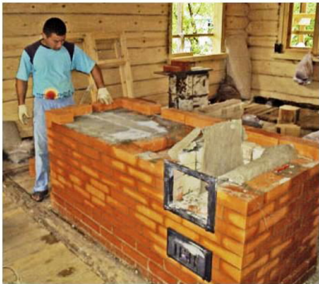
Между футеровкой топки и красным кирпичом проложен базальтовый картон для соблюдения равномерного зазора.
