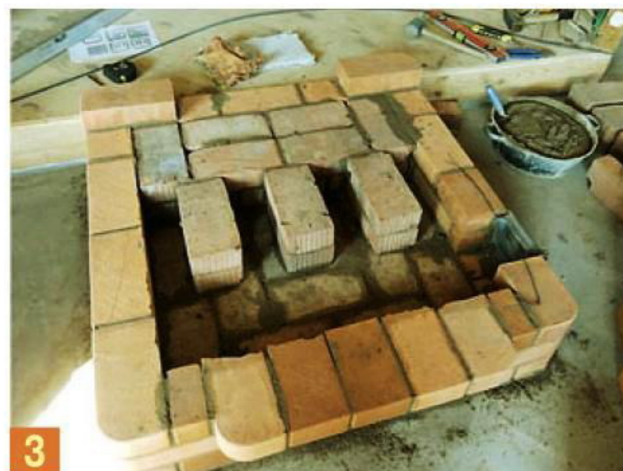
3 На третьем ряду кладки заложен дымоход печи, проходящий ниже пода камина.
