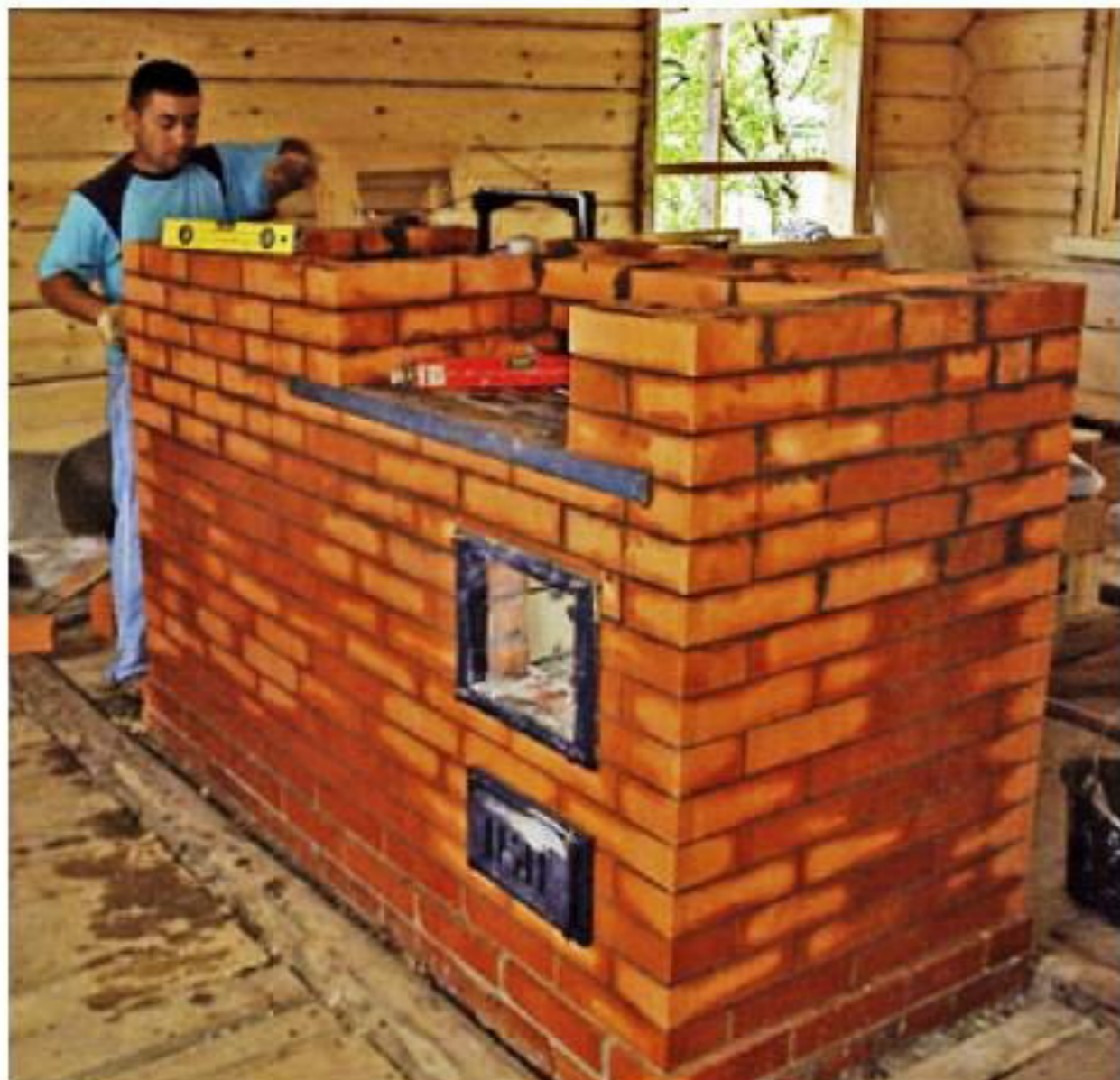
17-й ряд кладки. Строительный уровень — неизменный инструмент печника. Контроль ведётся на каждом кирпиче.
