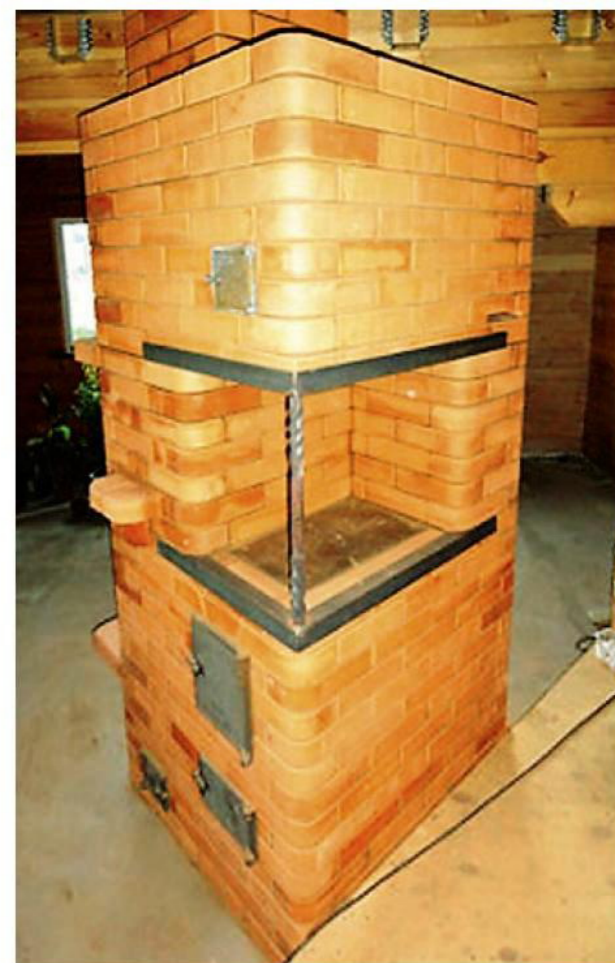
Печь ориентирована по диагонали, в связи с чем трубу на втором этаже пришлось развернуть на 45°.
