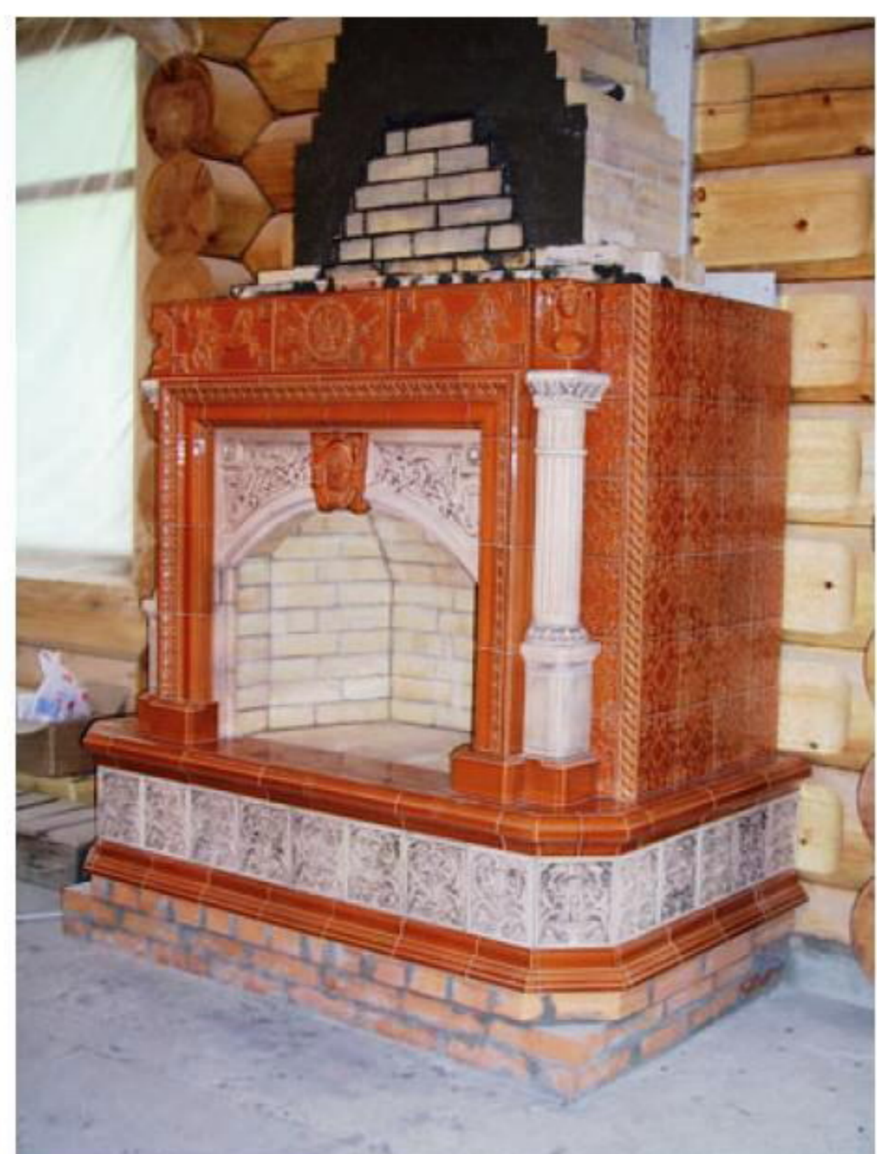
Монтаж изразцов близок к завершению. На очереди — карниз и полка камина.
